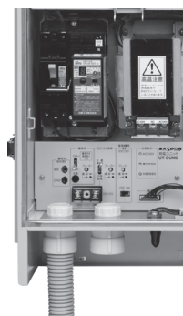
AC100Vケーブル引込口接続例
